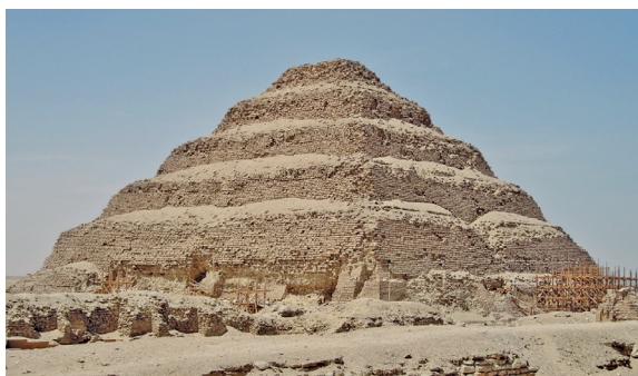
Pirâmide em degrau. Matéria-prima: tijolo de barro e pedra calcária, ausência de argamassa.
