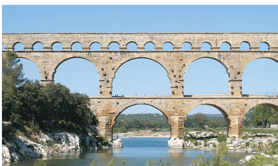
Os aquedutos demonstram o significativo desenvolvimento da engenharia romana, em especial pela utilização dos arcos e pela funcionalidade das obras.
