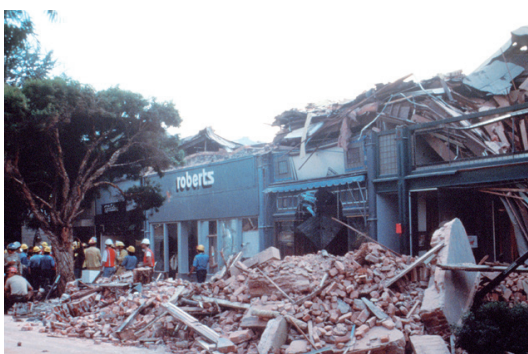
Destruição provocada por um terremoto.
