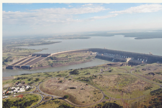
Usina hidrelétrica de Itaipu.
