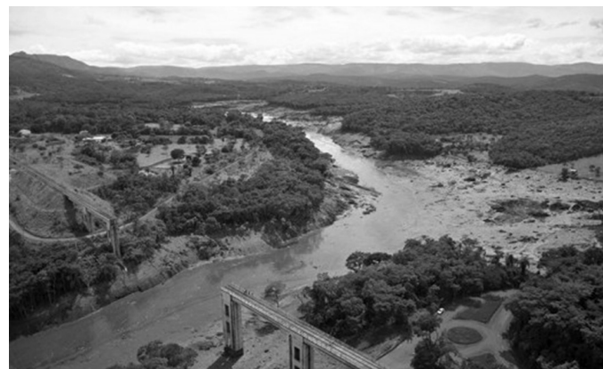
Figura 1 – Rompimento da barragem de Brumadinho
